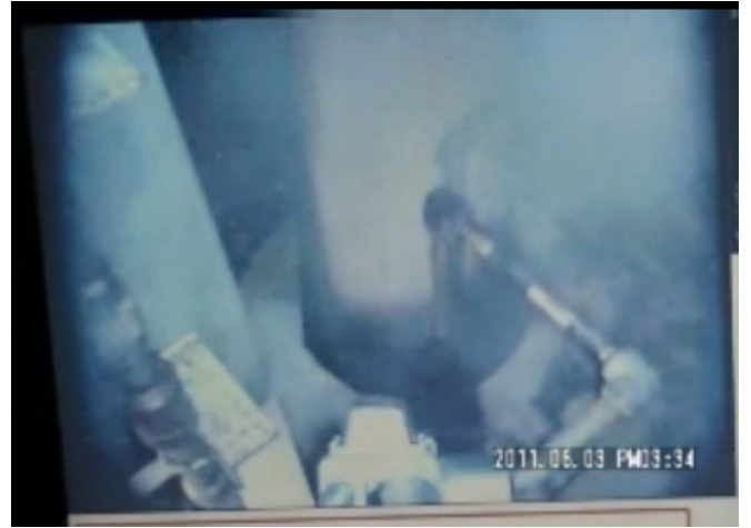
1号機の原子炉建屋1階における湯気確認状態 (東電提供)
