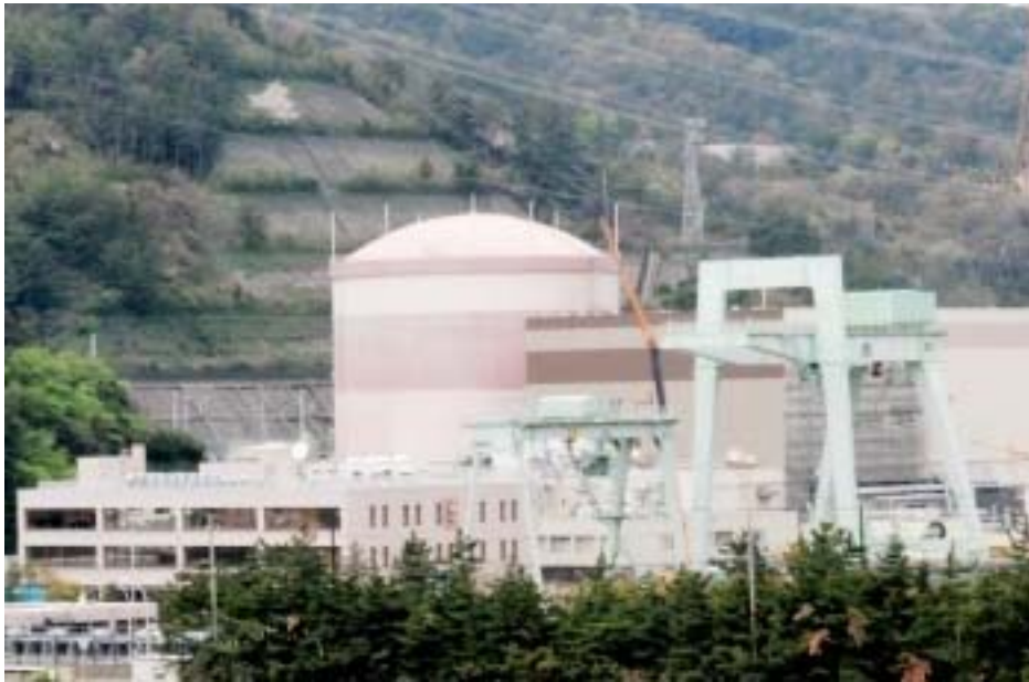
放射性廃液漏れ事故から30年が経過した日本原電敦賀原発1号機 = 4月、福井県敦賀市明神町
